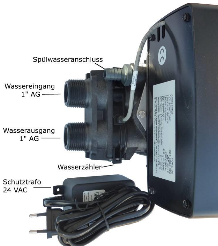
Abbildung 5: Anschlusskizze Steuerventil Fleck 5600 SXT
